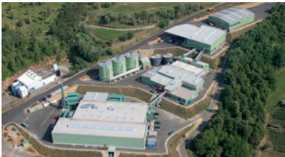
Das Foto zeigt eine Gesamtaufnahme der Mechanisch-Biologischen Anlage.
